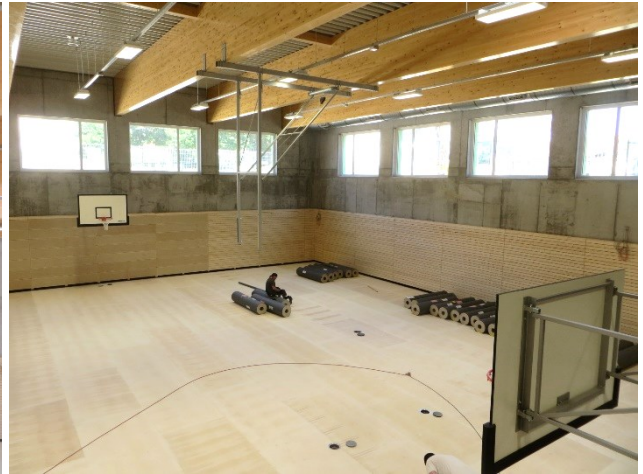
Sporthalle – Vorbereitung Sportbodenbelag
