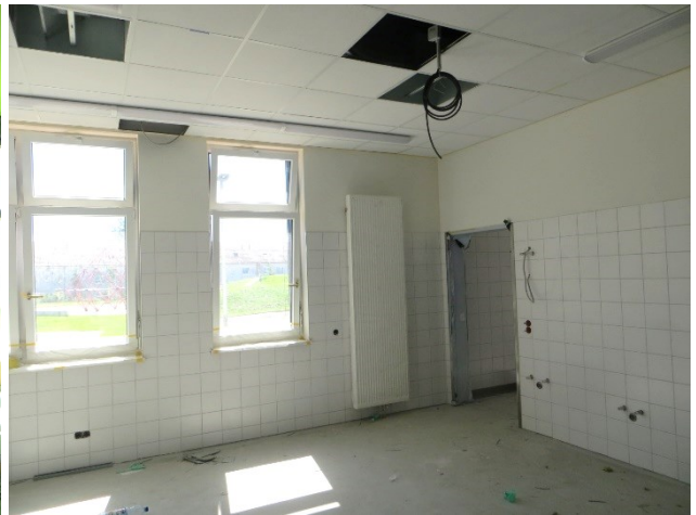
Küche – Komplettierung techn. Ausstattung Unterdecke
