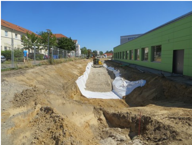
Herstellen Rigole entlang BT 04 Sporthalle
