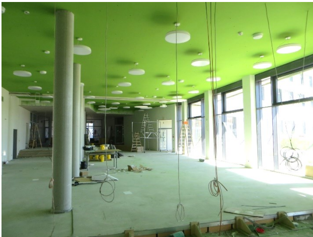
Mensa – Montage Leuchten und Akustkdeckensegel
