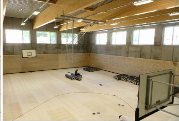
Sporthalle – Vorbereitung Sportbodenbelag
