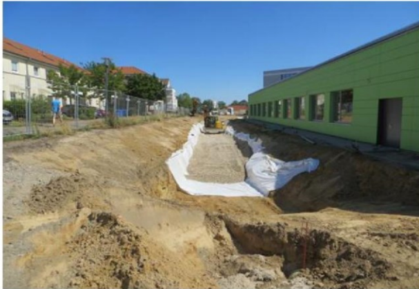
Herstellen Rigole entlang BT 04 Sporthalle
