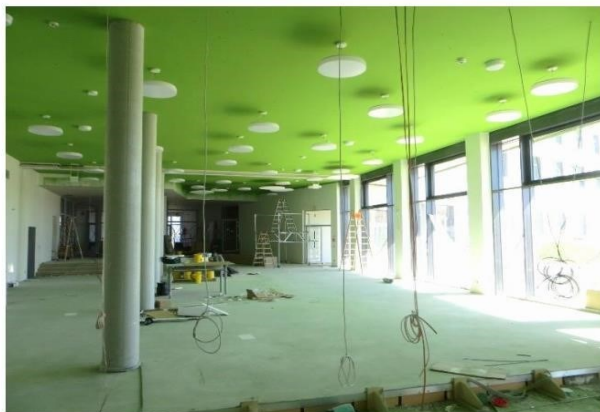
Mensa – Montage Leuchten und Akustkdeckensegel
