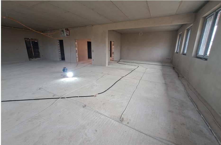
Bautenstand Montag, 08.01.2024, 9:00 Uhr (Blick in Sozialtrakt, OG, Schulungsraum + Jugendwehr)
