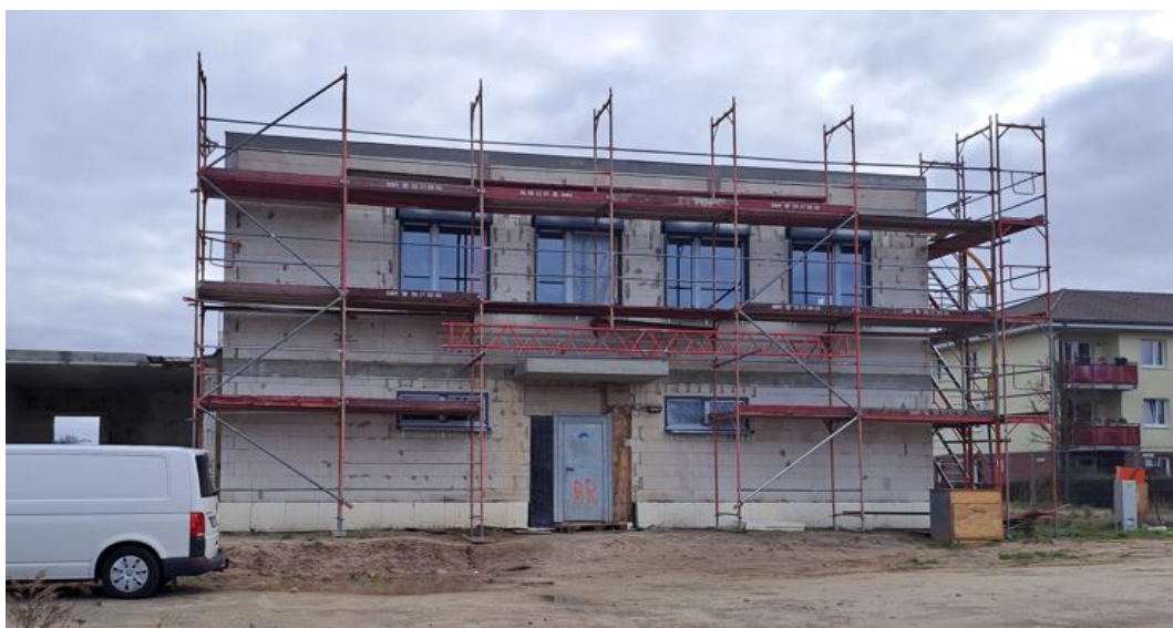
Bautenstand Montag, 08.01.2024, 9:00 Uhr (Blick Alarameingang Sozialtrakt)
