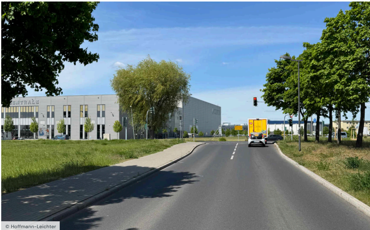
Bild 4 Wiesenstraße | Blickrichtung Nordwesten
