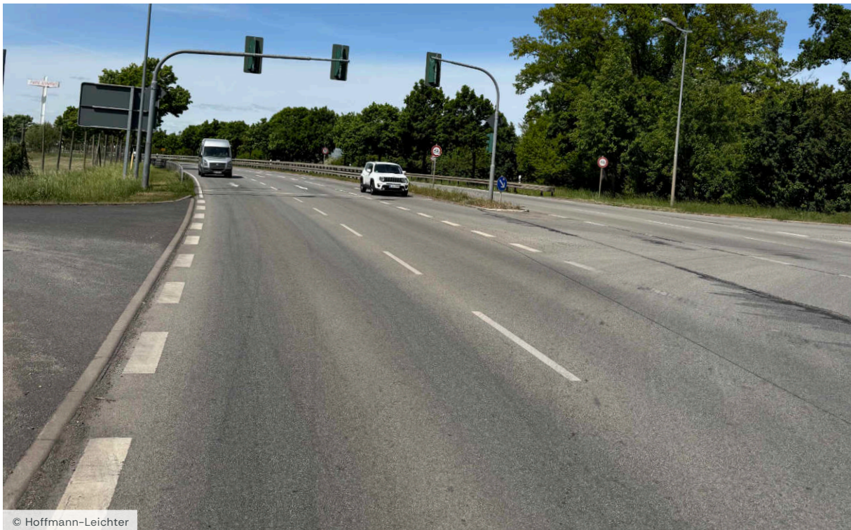
Bild 12 KP Neuer Hönowener Weg / Bundesstraße 1/5 | Blickrichtung Nordwesten
