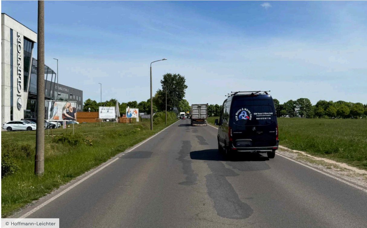
Bild 1 Neuer Hönower Weg | Blickrichtung Nordosten
