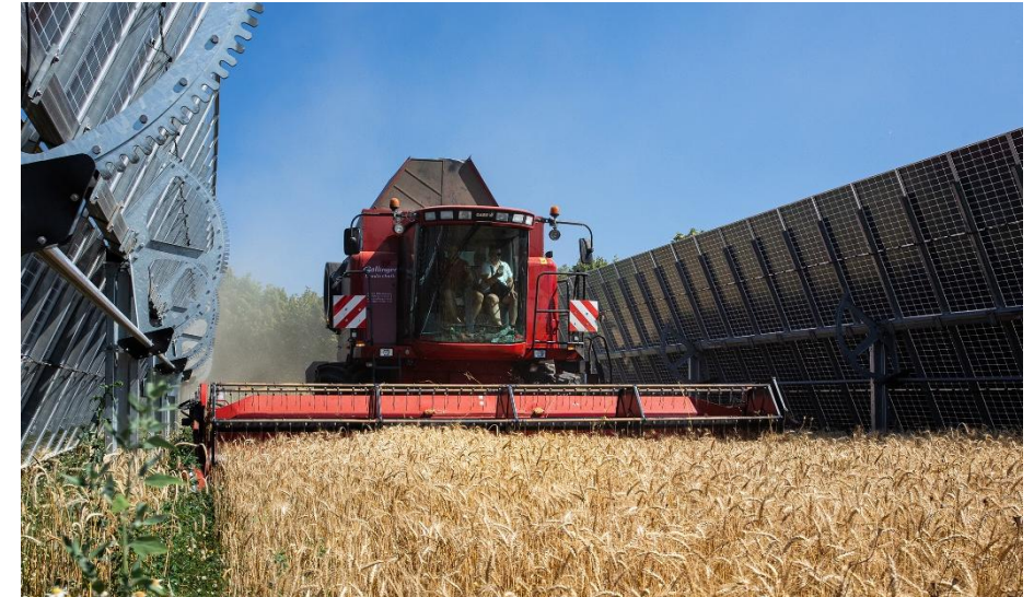
Agri-PV Anlagenlösung mit Trackern. Die Module sind vertikal gestellt, sodass die Bewirtschaftung der Fläche erfolgen kann.
