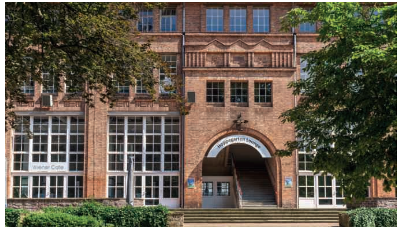
Fassade Haupttribüne Rennbahn Hoppegarten
